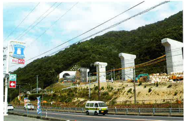
三原バイパス工事(中本憲司)
