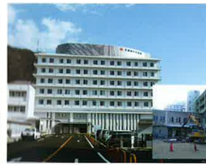
日赤新築と日赤解体工事(大澤則英)
