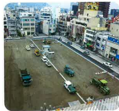
整地中のペアシティ跡地
