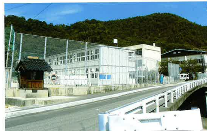
西小学校建替中
